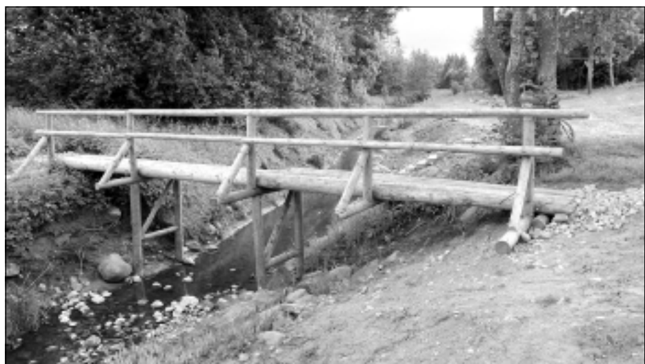
Pēc tīrīšanas. Pēc upes gultnes tīrīšanas apaugums upes krastos ir novākts, liekais ūdens ir aizplūdis, ir sakārtotas drenu iztekas un visas būves, kas saistītas ar ūdensteci. Būvnieks, kurš veica upes tīrīšanu, ir uzbūvējis pār upi tiltiņu. Kādā citā vietā pie upes izveidots brasls lopu pārdzišanai no viena krasta uz otru. Praktiski un skaisti!
