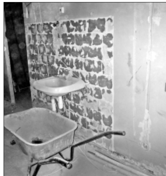
Pārvērtības. Tā izskatās telpās, ko patlaban remontē.
