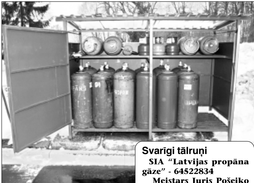
Gāzes balonu punkts. Balvos ir pieci gāzes balonu piegādes punkti, kur tos pieved no Valmieras.
